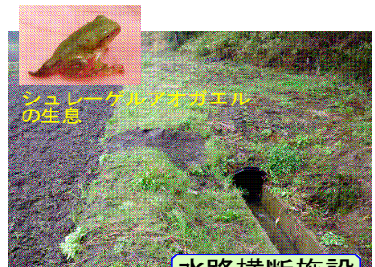
水路横断施設
