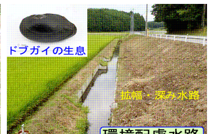
環境配慮水路
