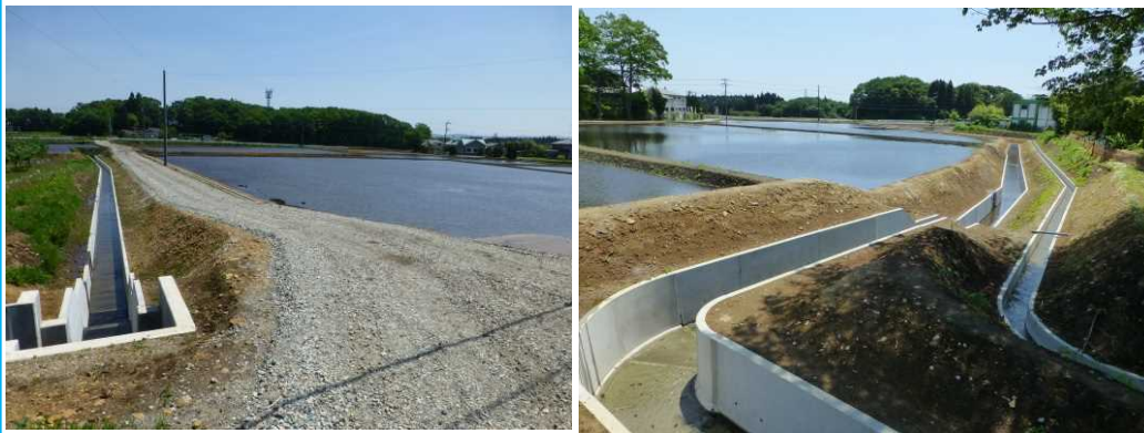
H27年度工事により整備された圃場及び水路・道路
