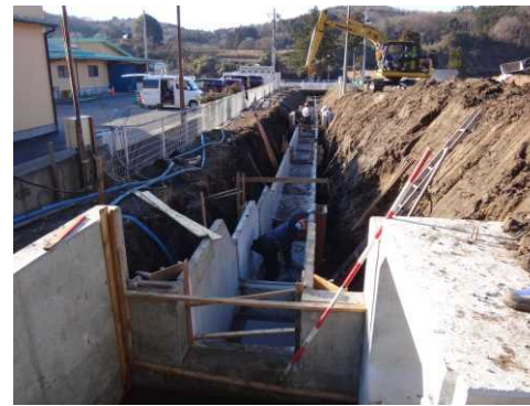
高内地区の排水路整備
