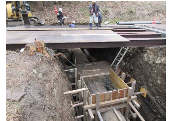
管水路の改修状況
