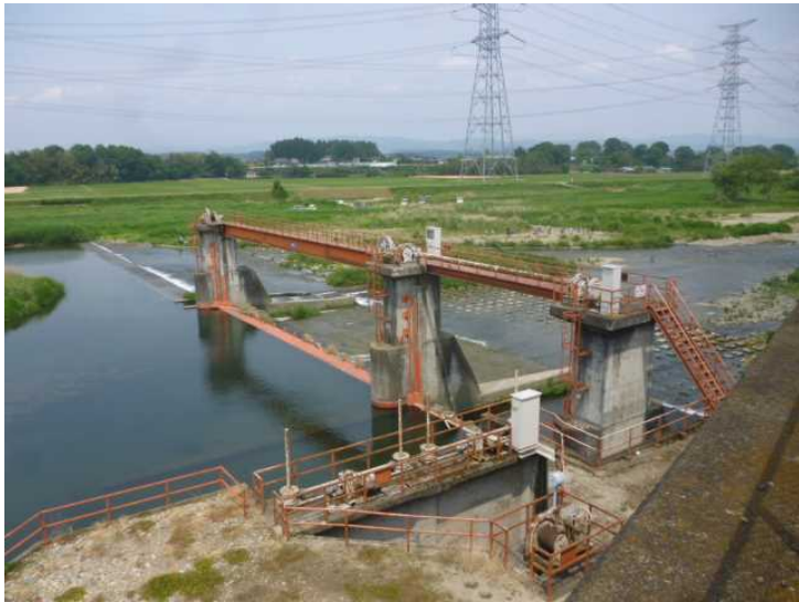
改修予定の西の原頭首工
