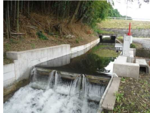
整備された刈沼川と自動転倒堰
