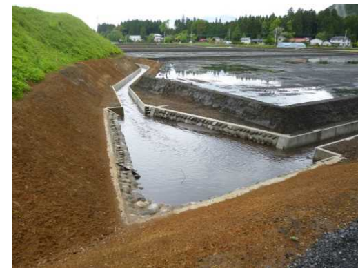
生態系保全水路
