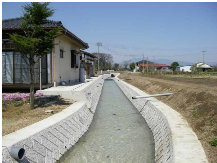
完成した水路に水が流れた！
