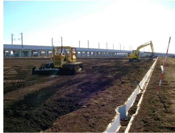
工事真っ盛り
