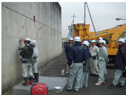
コンクリートはつり試験の状況
