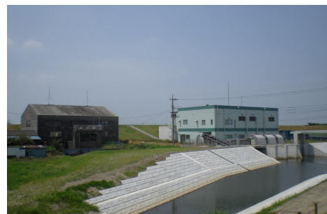
写真2 吾妻排水機場（佐野市）
