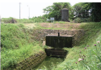
小藪集水渠(壬生町)
