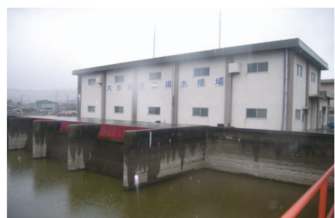
写真2 大岩藤第2揚水機場（岩舟町）
