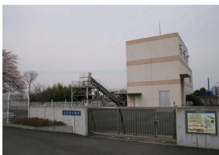
写真1 塩沢排水機場（小山市）
