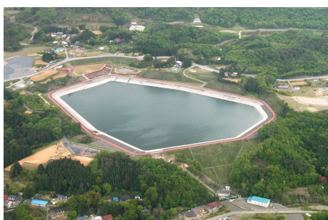
写真1 塩田調整池(市貝町)
