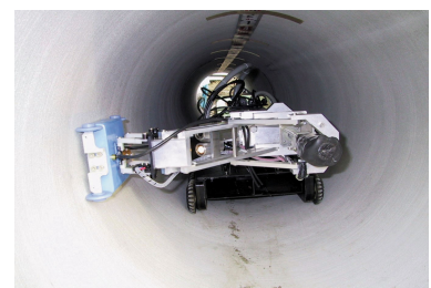
電磁波による管内の詳細調査
