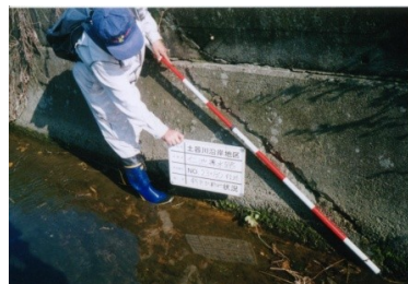
目視によるひび割れの確認
