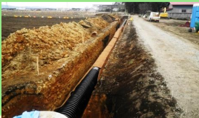
排水路の暗渠化
