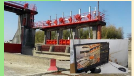
水利施設の遠隔監視システム
