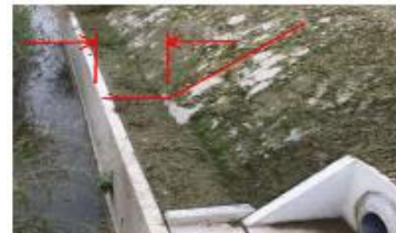
水路末端(犬走り)に歩行・作業スペースの確保
