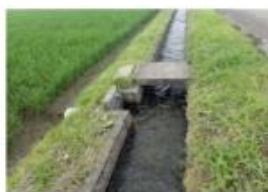
水管理時の足場確保のための水口蓋の設置 (コンクリート蓋、網鋼板)
