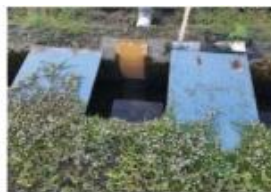
水管理時の足場確保のための水口蓋の設置 (コンクリート蓋、網鋼板)
