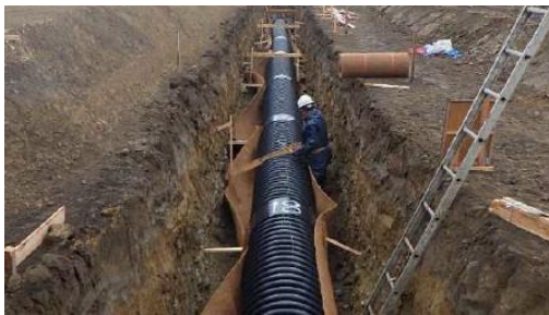
図 5-6-2 ポリエチレン管敷設状況
