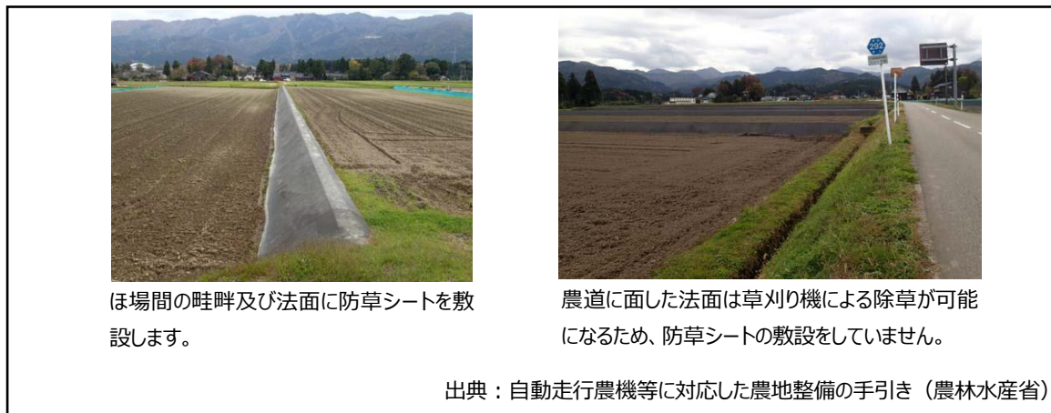
図 5-10-6 法面に防草シートを敷設し、維持管理を省力化した事例
