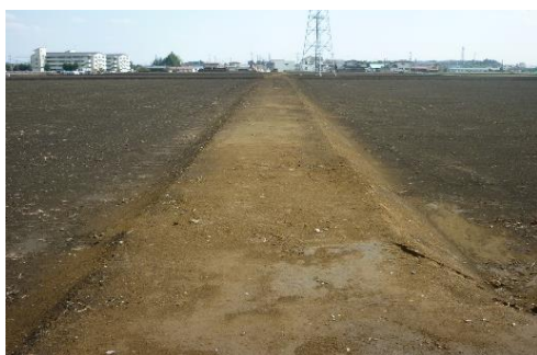
図 5-6-9 暗渠化された排水路
