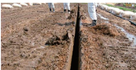
図 5-3-4 FOEAS 施工状況
