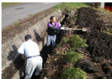
写真1 水路の土砂さらい
