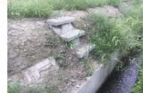
法面における階段の設置
