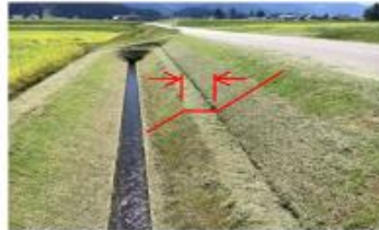
小段の設置による歩行・作業スペースの確保
