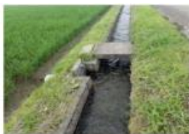
水管理時の足場確保のための水口蓋の設置 (コンクリート蓋、錆鋼板)
