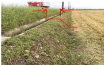
溝畔の復旧、整形による歩行・作業スペースの確保
