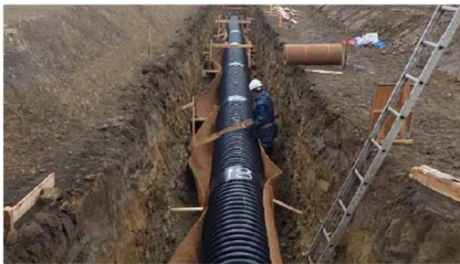
図 5-6-2 ポリエチレン管敷設状況
