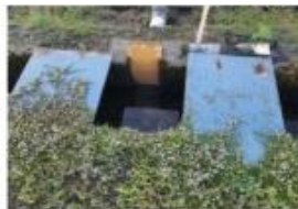
水管理時の足場確保のための水口蓋の設置 (コンクリート蓋、錆鋼板)
