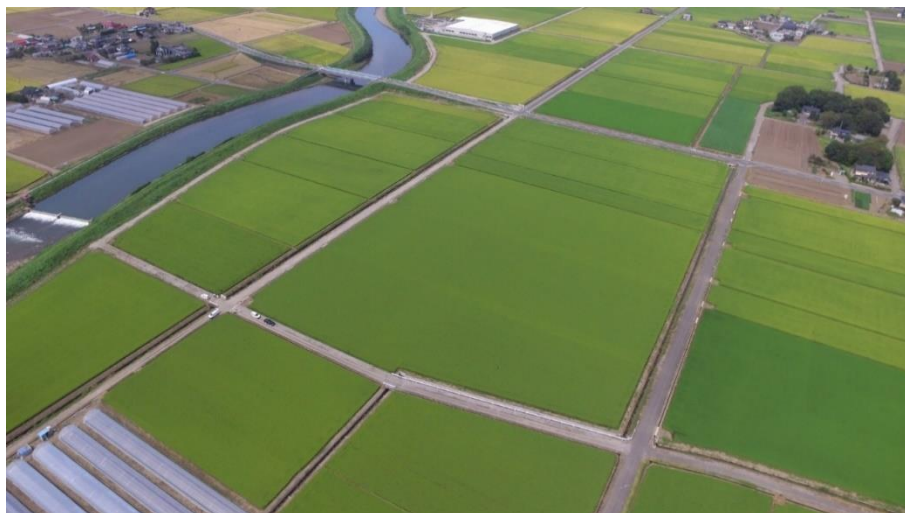
図 5-1-1 大区画で整備されたほ場（下野市）
