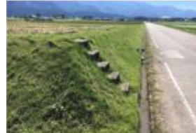
法面における階段の設置
