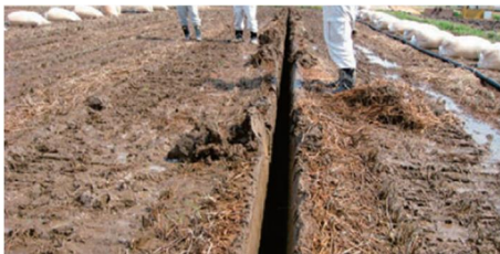
図 5-3-4 FOEAS 施工状況
