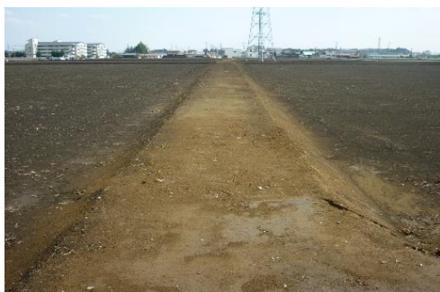
図 5-6-9 暗渠化された排水路
