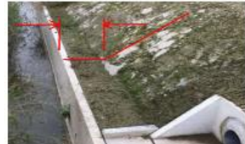
水路天端(大走り)に歩行・作業スペースの確保
