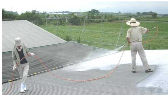
（屋根への石灰吹きつけ）
