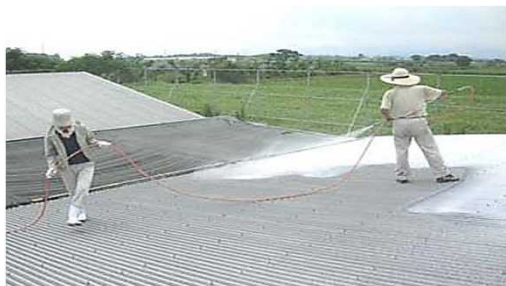
屋根への断熱資材（石灰）塗布作業 ⇒ 屋根裏温度5℃以上の低下
