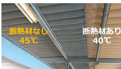
屋根裏断熱材の有無による放射熱の比較
