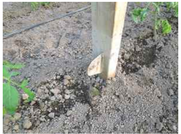
埋設してしまった基礎部分。
