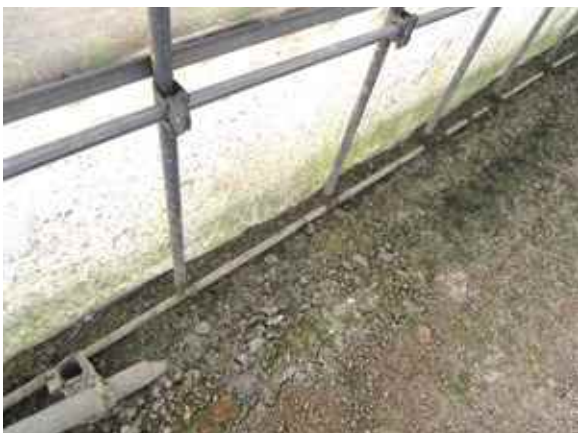
根がらみは埋設していないが雪には効果有り。埋設すると耐風力も向上。
