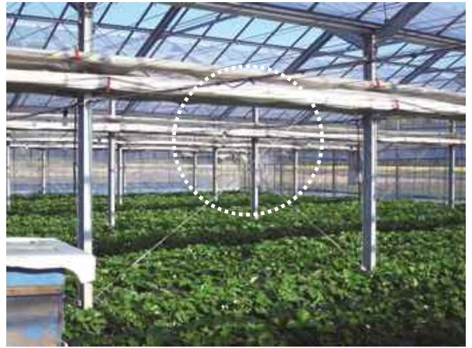
ブレースが確実に設置されている。
