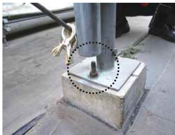
柱はベースプレートと接するように設置すると補強効果が高くなる。
