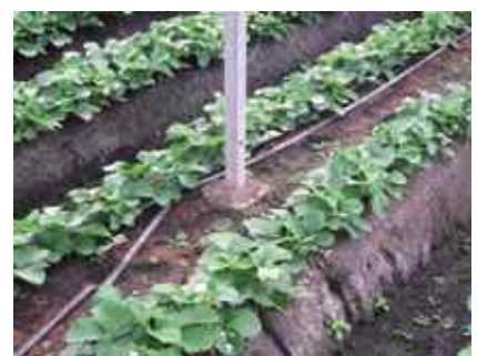
いちごの畝間に設置された基礎。
