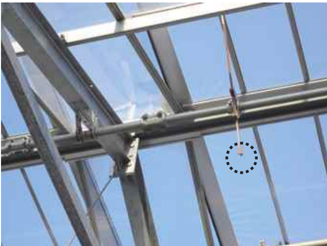
天窓のラックピニオン抜け防止にネジ止めされている(左)。天窓の両端だけでもネジ止めしてあると効果がある。通常は右のように穴が空いている。
