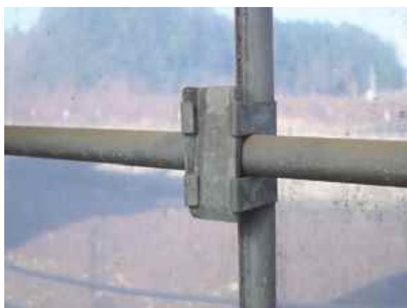
鋼板製金具でしっかり固定する。
