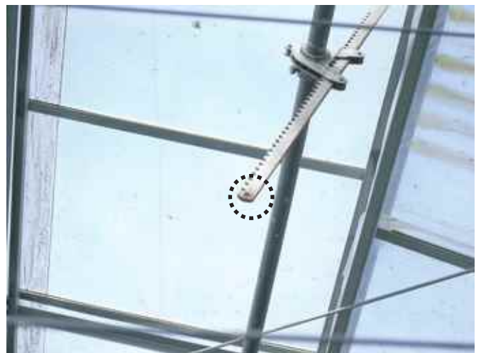
天窓のラックピニオン抜け防止にネジ止めされている(左)。天窓の両端だけでもネジ止めしてあると効果がある。通常は右のように穴が空いている。
