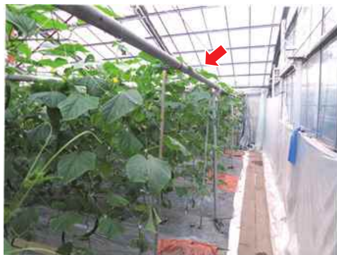
ハウスとは別に設置した足場管に誘引線を通し、作物荷重を分散させている。
