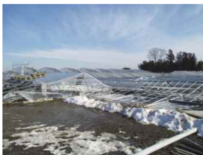
明け方の強風で、基礎のベースプレートから破断し横倒しになった。
