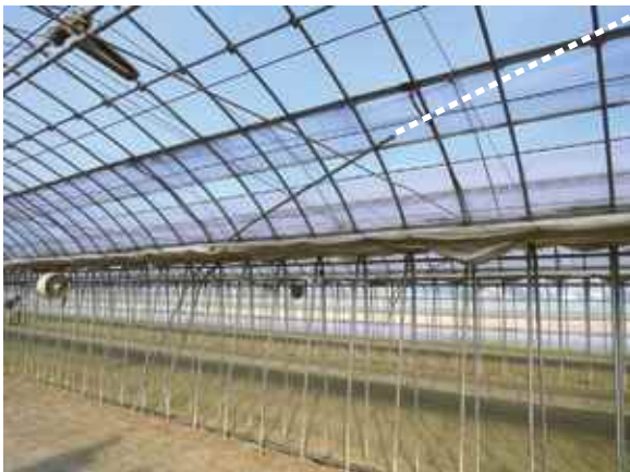
筋交いが入っているものの短く不十分。妻面までの延長が必要。
