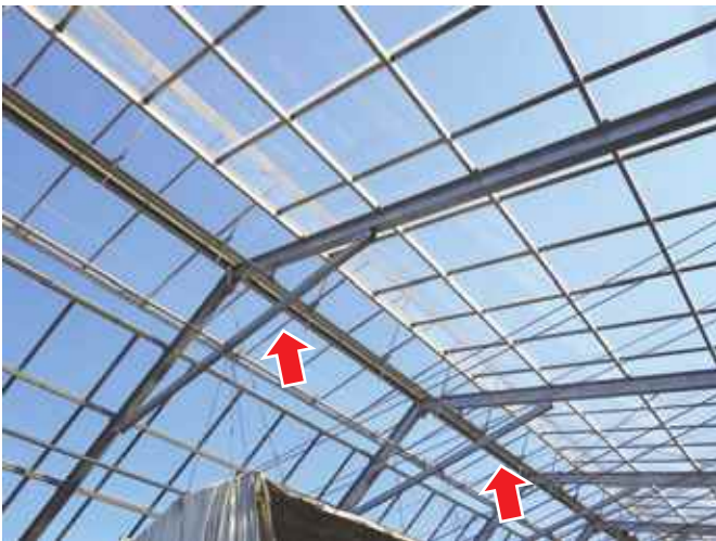
タイバーが設置されている。
