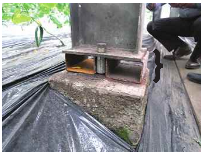
勾配も定期的に取り直し、雨水の排水に努めている。
