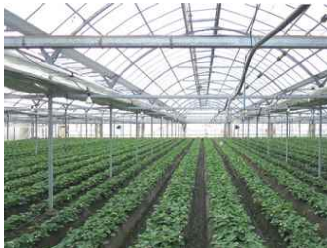
いちごハウスには十分な角形鋼管(□-50×50)による水平ばりが入っている。
