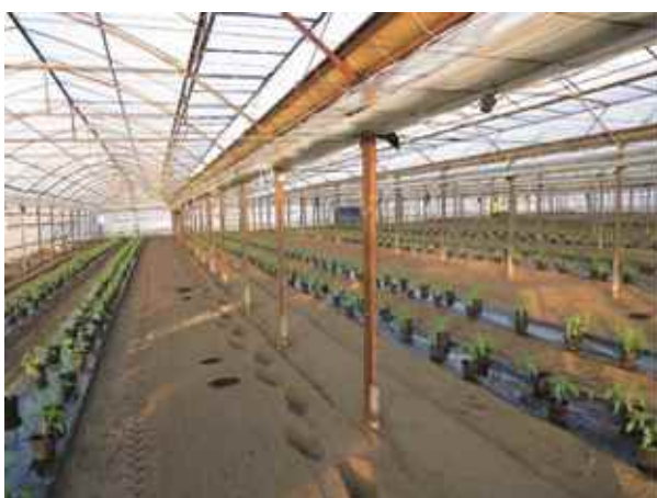
耐雪強度が低いAPハウス。(アングルパイプハウス)
