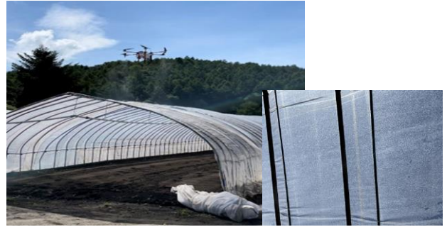
ドローンによる塗布作業
