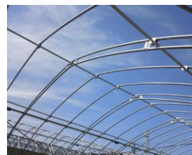
ダブルアーチによる補強
