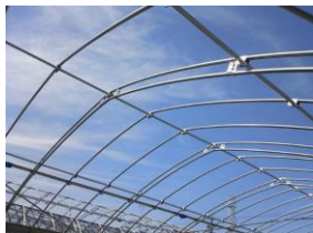
ダブルアーチによる補強
