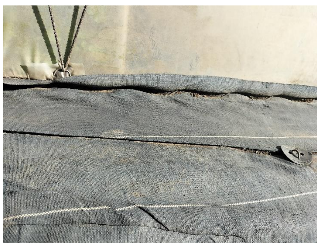
図32 ビニペットによる固定
