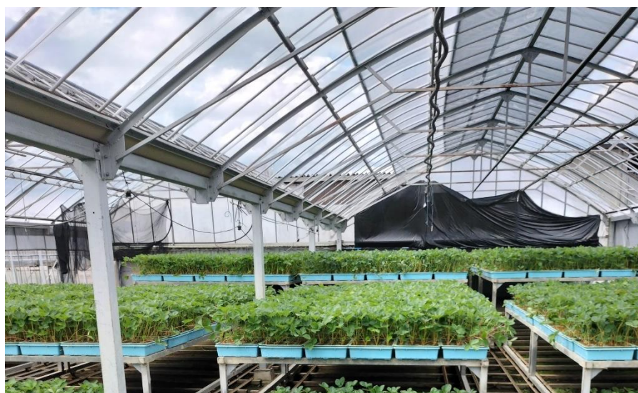
図 13 換気窓と遮光ネットを可動式にした育苗ハウス
