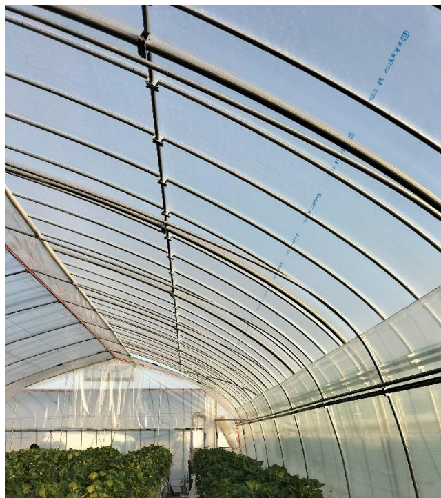
図 27 単管パイプによる補強
