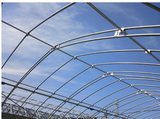
図 26 ダブルアーチによる補強
