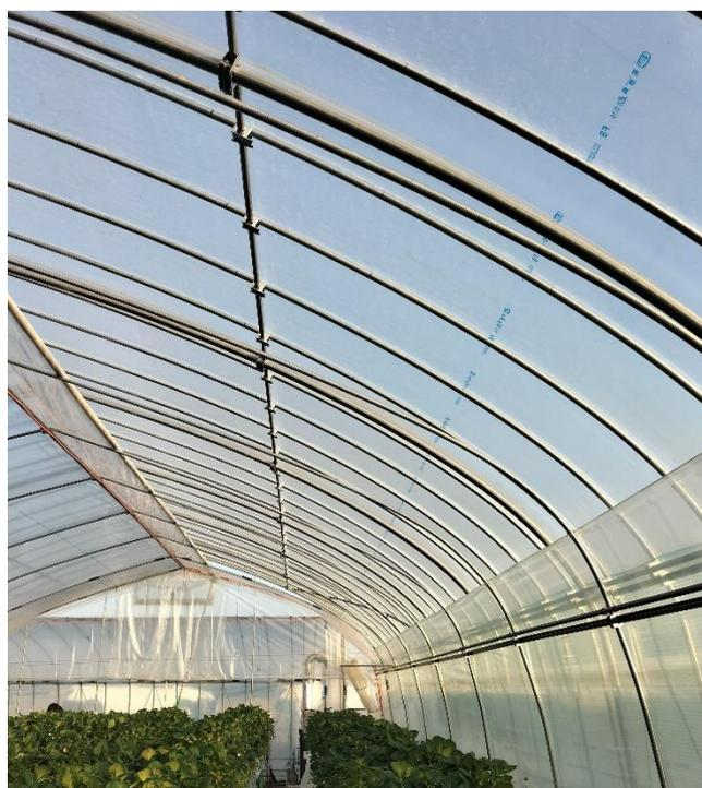
図 27 単管パイプによる補強
