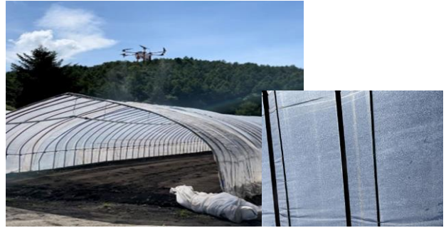
ドローンによる塗布作業
