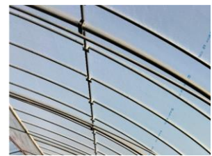
単管パイプによる補強
