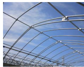
ダブルアーチによる補強
