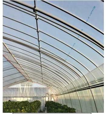
単管パイプによる補強
