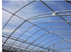
ダブルアーチによる補強
