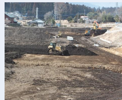
基盤整備工事の実施状況
