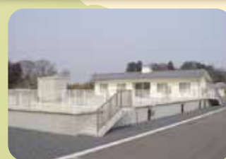
農業集落排水処理施設
