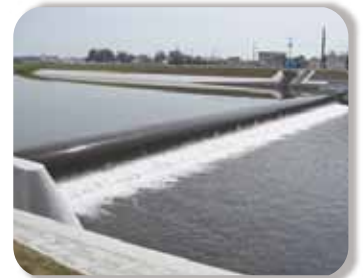
整備された取水堰（強口堰）
