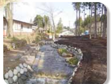
生態系に配慮した工法を取り入れた水路
