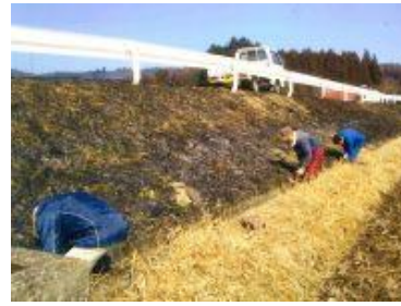
水路の清掃・補修作業 (那須塩原市)
