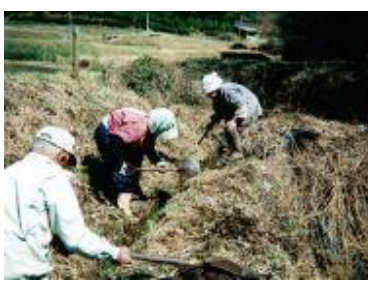
水路の泥あげ作業 (那珂川町)
