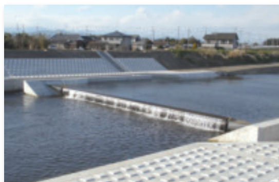
更新整備された川島堰（栃木市、小山市）
