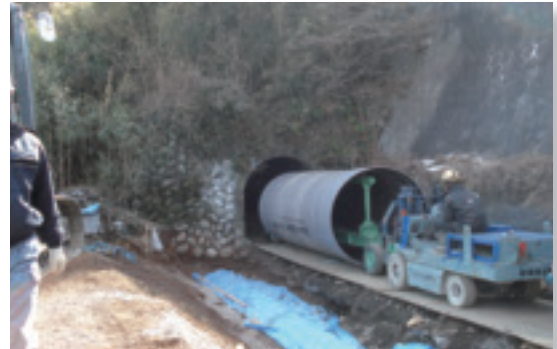
新技術による対策工事中のずい道（古用水地区）
