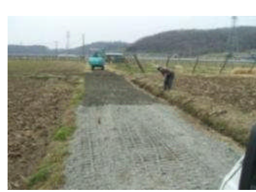
農道の補修により大型機械の走行性が向上
