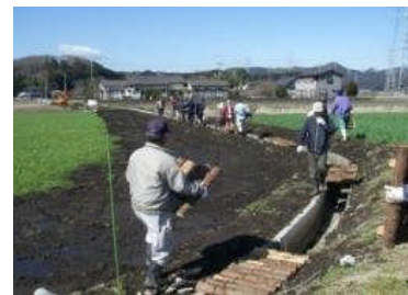
カエルの移動経路に 配慮した蓋の設置 (間伐材利用)
