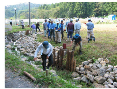
企業と連携の下、農業用水としての機能維持と親水性に配慮した水路補修を実現
