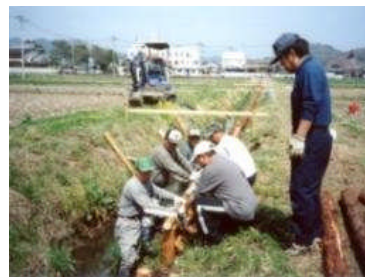
水路の補修には地元ヒノキ間伐材を使用(約1,000本)
