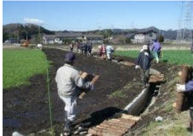
カエルの移動経路に配慮した蓋の設置 (間伐材利用)
