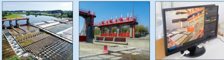
整備後の美田東部頭首工の全景、取水口及び監視モニター
