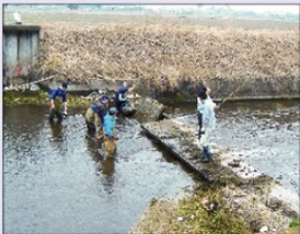
整備前 転倒ゲート等がありず 増水時に障害
