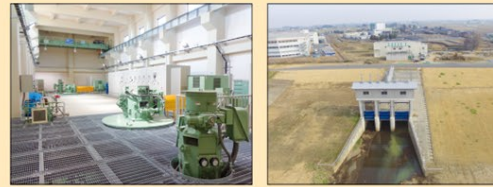
排水機場の整備
