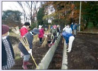
水路の泥上げ
