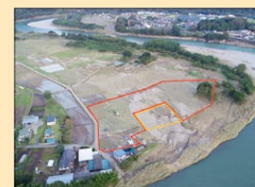
被災状況(土砂堆積)
