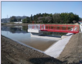
整備後 堤体をブロックで改修
