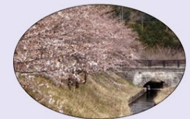
那須疏水 幹線水路
