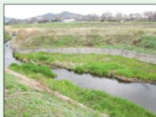
環境配慮水路工(ワンド)
