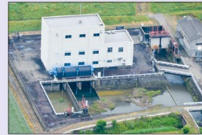
洪水被害から地域を守る排水機場
