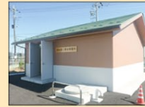
小水力発電施設
