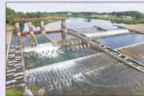
河川から農業用水を取水する頭首工
