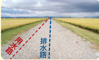
用排水路の暗渠化による農道の拡幅
