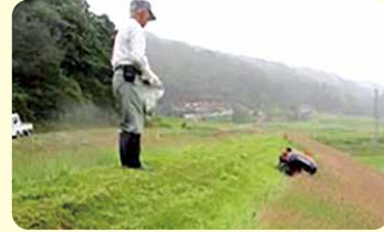
緩勾配の法面での安全な除草作業
