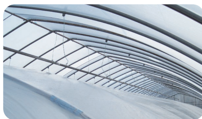
ウォーターカーテンを導入したハウス（設置したパイプから水を出し保温）
