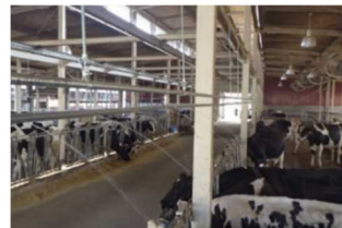
散水システム及び稼働状況
