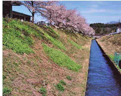
那須疏水幹線水路
