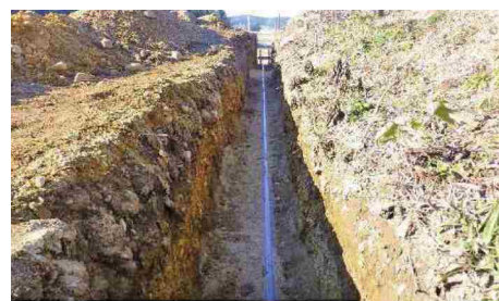
パイプライン布設状況
