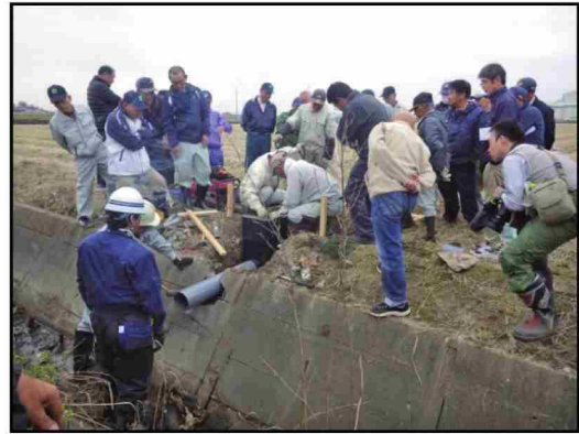
落水柵の設置状況
