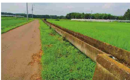
施工前のコンクリート開水路
