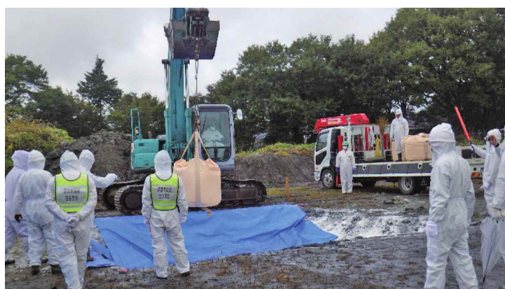
重機を使用した汚染物品等の埋却
