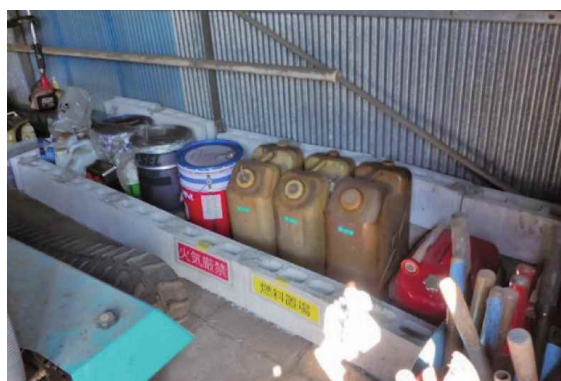
燃料置場に防油堤を設置
