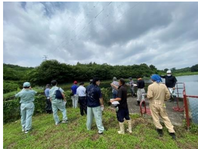
堤体法面を点検している様子
