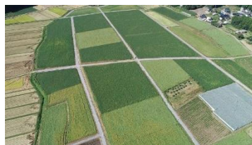
整備後の大区画化した畑地
