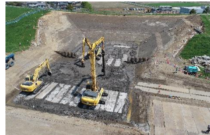
パワーブレンダー工法 (地盤改良)
