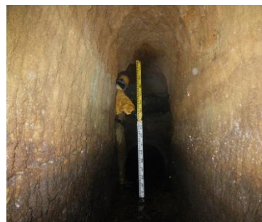
整備前のずい道
