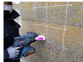
中性化試験の様子
