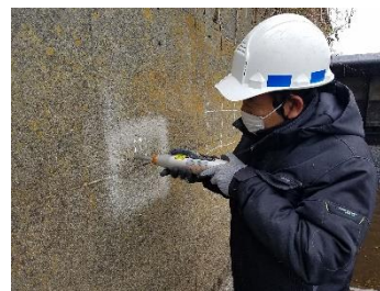
コンクリートの強度試験の様子
