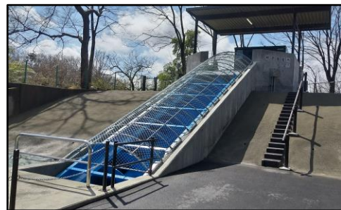
水路落差(約4m)部に らせん水車を設置
