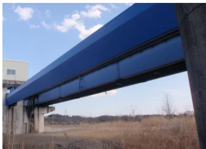
洪水吐、管理橋の塗装
