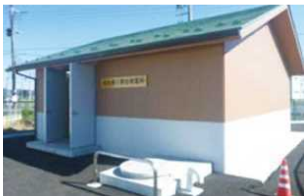
地域用水環境整備事業で整備した 待矢場三栗谷発電所(小水力発電施設)
