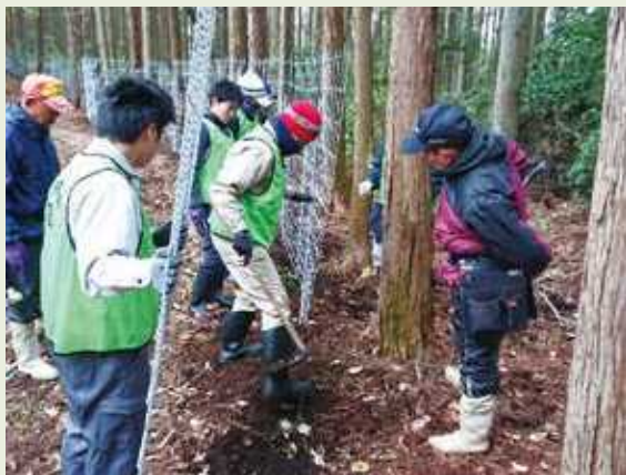
獣害防護柵の設置
