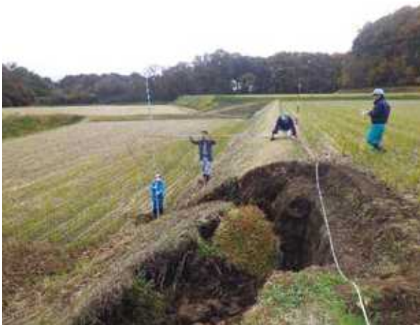
写真12 畦畔崩落現場の測量
