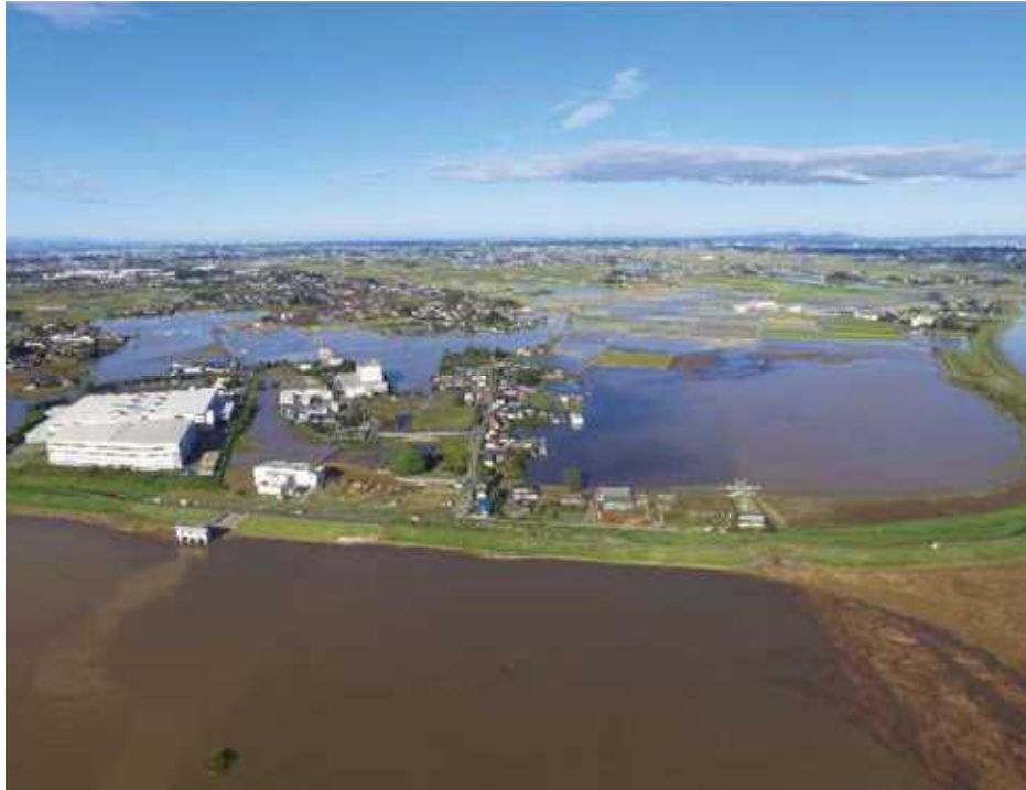
写真11 西前原排水機場周辺の湛水状況(令和元年10月13日撮影)
