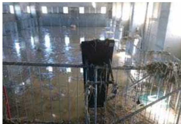
写真8 揚水機場の水没
