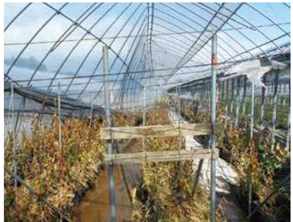
写真5 冠水したパイプハウス内部(りんどう)
