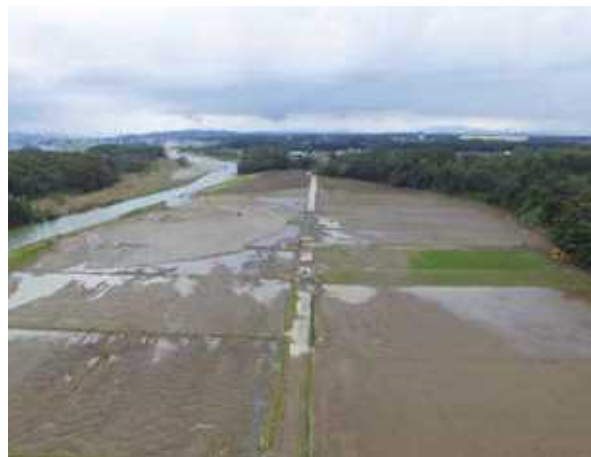
写真6 堤防決壊による農地への土砂流入
