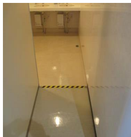
トイレ入り口段差に注意喚起表示。 ならびに清掃中の転倒防止。
