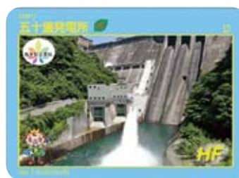
[発電所カード]
