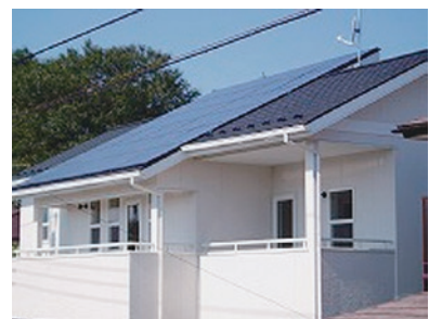
一般住宅 4.5kw システム
