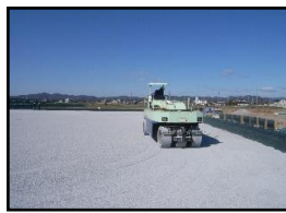
Yミックスを施工している様子
