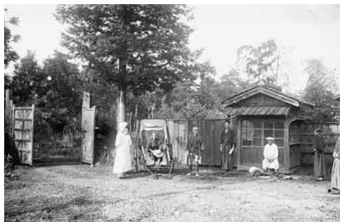
全生病院（現・多磨全生園）の収容門＝大正期
