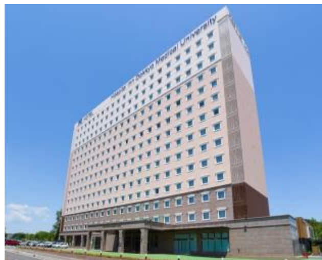
敷地内ホテル
