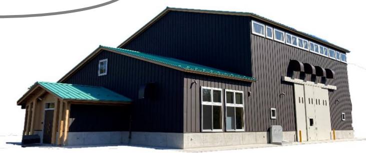
全天候型実習棟
